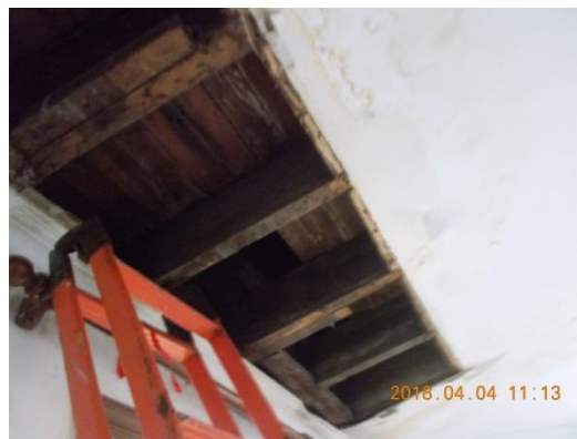
二层楼面木格栅、楼面腐朽
