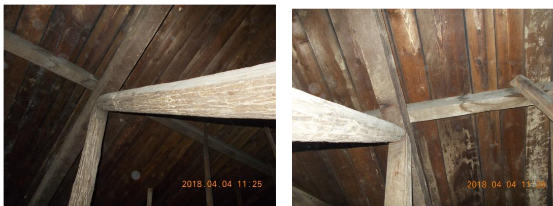
木檩条、望板渗水腐朽
